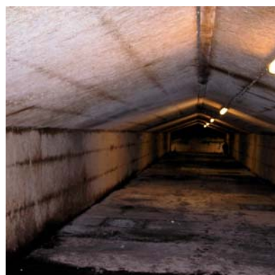
Selvom kanalen af krydsfiner er isoleret, så dannes der svampe på pladerne.
