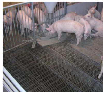
Sti med støbejernsgulv med slibespor i gødearealet.
