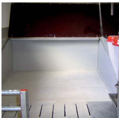
Indretningen af stierne, hvor gulvet overfladebehandles.
