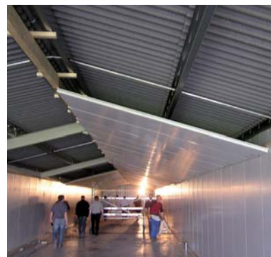
Sandwichelementer med glatte overflader er rengøringsvenlige.
