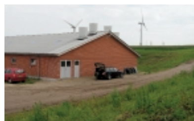
Biologisk luftvasker: Afgangsluften samles i en kanal i loftrummet og føres til den centrale luftrenser med to sæt lameller i enden af bygningen.
