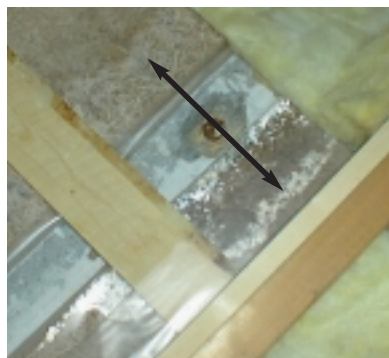
Figur 1. Luftpassage mellem to sektioner i hulrummet mellem forskallingsbrædder og isolering.
