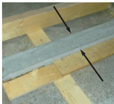
Figur 2. Ingen risiko for luftpassage mellem forskellige sektioner, idet forskallingsbrædderne afbrydes ved sektionvæggen.
