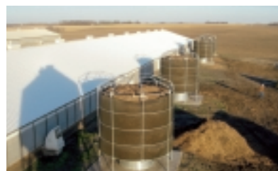
Biofilter: Et muligt alternativ til de pladskrævende vertikale biofiltre (eksemplet er fra USA).
