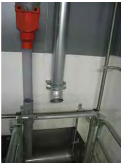
Krybbeventil hvor luften ledes direkte til hovedet af soen.
